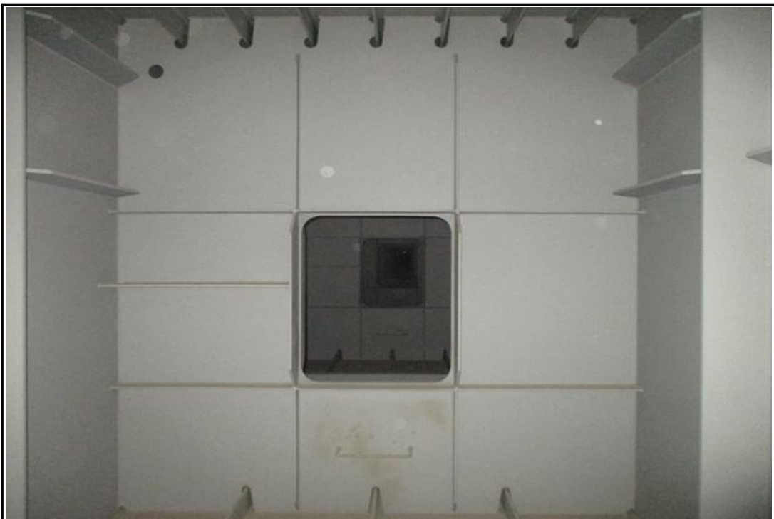
강박스 내부 전경
